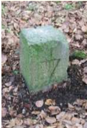
Nassauische Vermarkung III. Ordnung (Prinzipische Skizze und Trachtypfeiler auf dem Buchwaldskopf bei Oberjosbach
